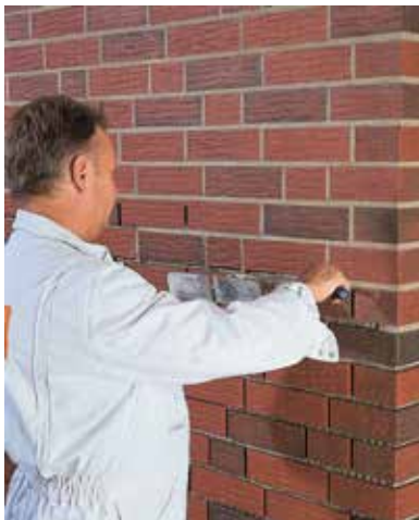
spárování obkladu spárovací maltou quick-mix FM
