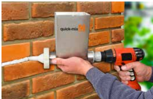
Rychlé strojní spárování pomocí strojního aplikátoru a spárovací hmoty FM-X. Po zavadnutí aplikované FM-X do polosuchého stavu se spára upraví například kusem hadice a suchým smetáčkem.
