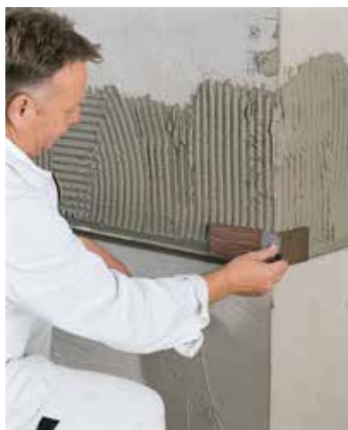
založení rohového cihlového pásku
