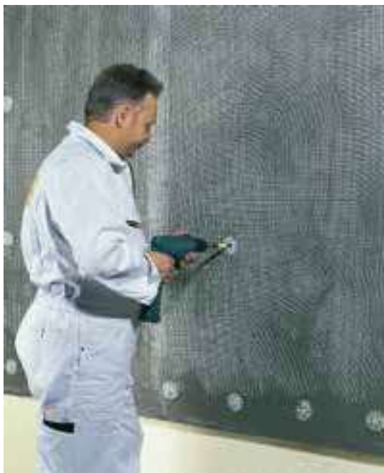
montáž kotvení šroubovacími hmoždinkami přes pancéřovou armovací tkaninu
