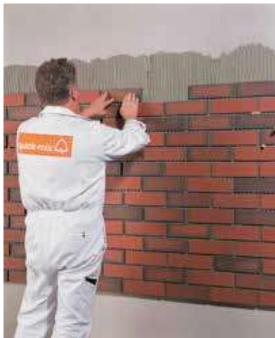
lepení cihlového pásku v ploše
