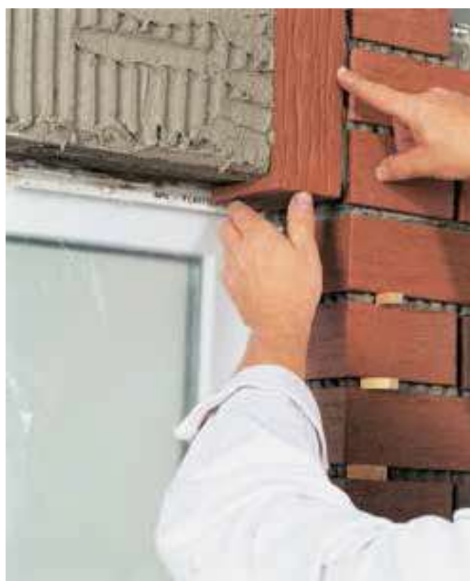
lepení cihlových pásků maltou quick-mix RKS na nadpraží stavebního otvoru
