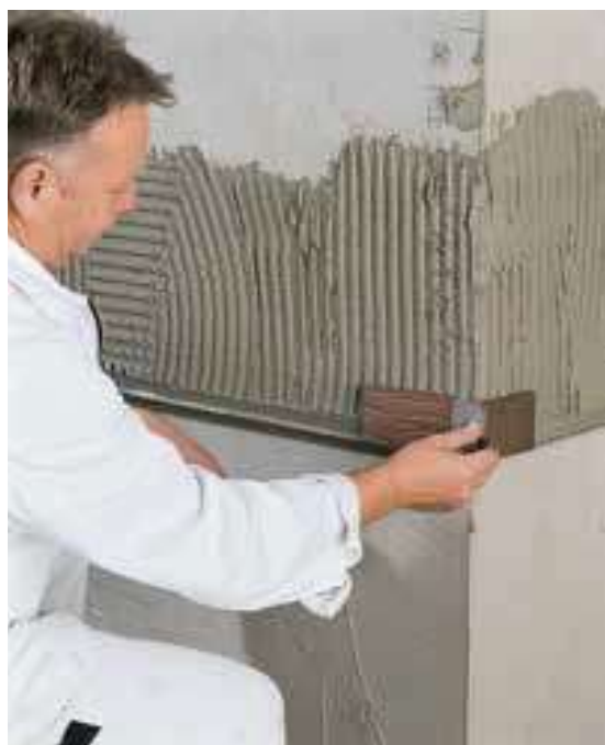
založení rohového cihlového pásku
