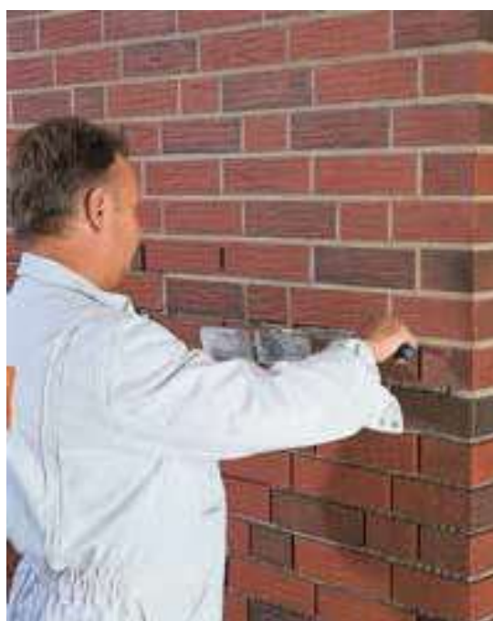
spárování obkladu spárovací maltou quick-mix FM
