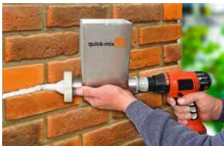
Rychlé strojní spárování pomocí strojního aplikátoru a spárovací hmoty FM-X. Po zavadnutí aplikované FM-X do polosuchého stavu se spára upraví například kusem hadice a suchým smetáčkem.
