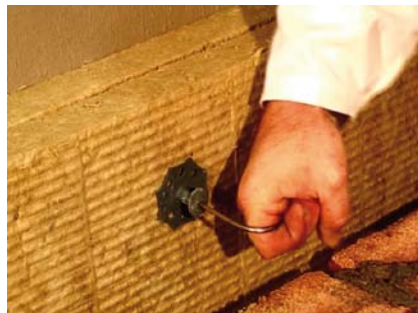
Krok 15 Přečnivající trn opět ohneme ve směru probíhající ložné spáry.
