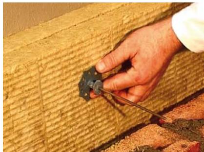
Krok 14 Podložku po jejím nasunutí pootočíme o 90° a tím docílíme fixace tepelně izolační desky.
