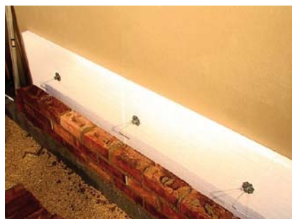
Krok 18 Detail rozmístění kotvicího systému. Kotvení provádíme průběžně s vyzdíváním líčového zdiva.
