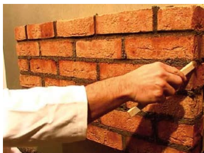
Krok 18 Konečnou podobu spar dotvoříme pomocí spárovacího v tomto případě vyroben z dřevěného kolíku.
