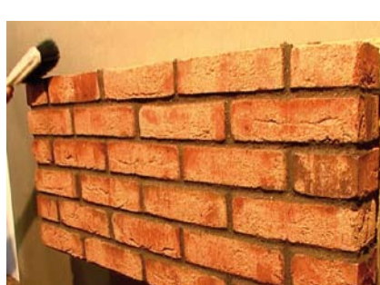
Krok 19 Konečným a posledním krokem je ometení celé plochy vhodně hrubým koštětem.
