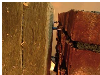
Krok 17 Díky tixotropní vlastnosti zdíček malt quick-mix V.O.R. zůstává vzniklá vzduchová mezeira naprosto volná. Tímto umožňuje splnit veškeré požadavky na její funkci.
