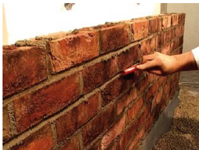
Krok 22 Konečné zpracování podoby spáry pomocí půlkulatého plastového přípravku. Tuto úpravu provádíme po zavaznutí malty ve spáře, před jejím zatvrdnutím.
