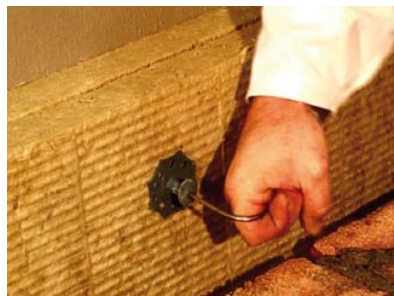
Krok 15 Přečínávací trn opět ohneme ve směru probíhající ložné spáry.
